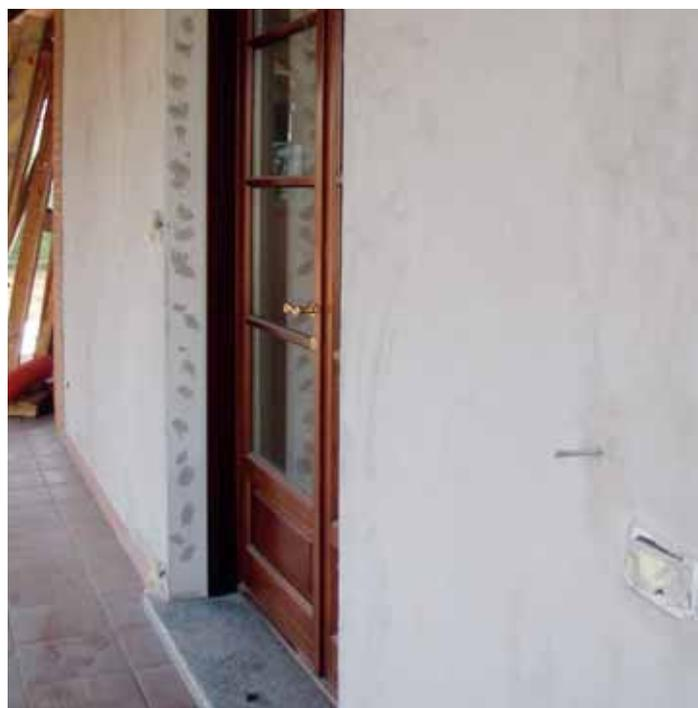
Prima fase di rasatura di muro esterno con FIBROFIN miscelato con RASATUTTO SUPERIOR.
