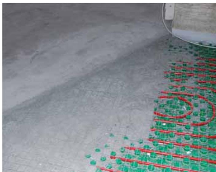
Posa di SUPER SABBIA E CEMENTO FIBRORINFORZATO per la realizzazione di pavimento riscaldato con pannelli radianti.
