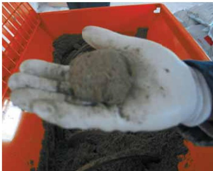
Il massetto impastato deve avere una consistenza "terra umida".
