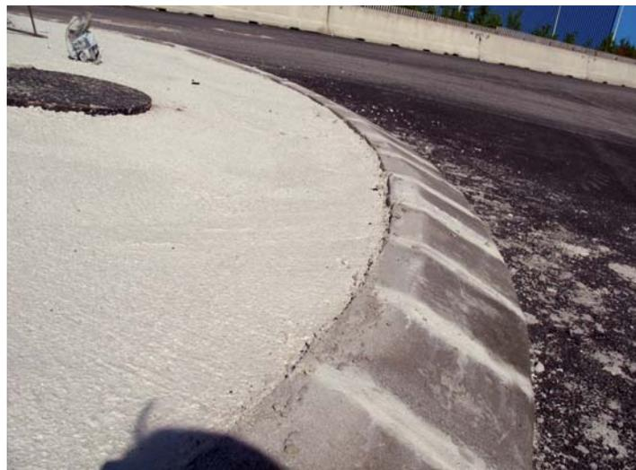
Lavori stradali realizzati con BETONRAPID (rotonde e inghisaggio chiusini) in cui è determinante la rapidità di asciugatura del prodotto.
