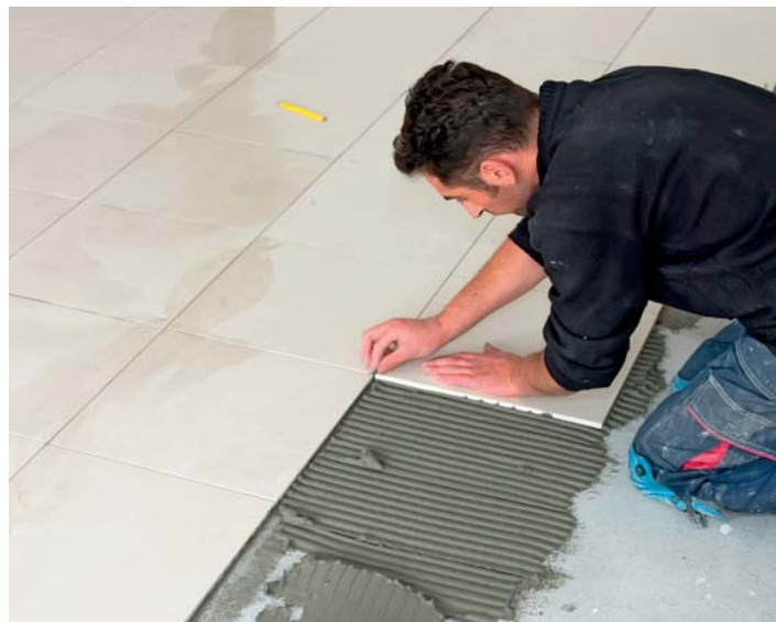
Posa di ceramica di grande formato con COLLA GRIGA
