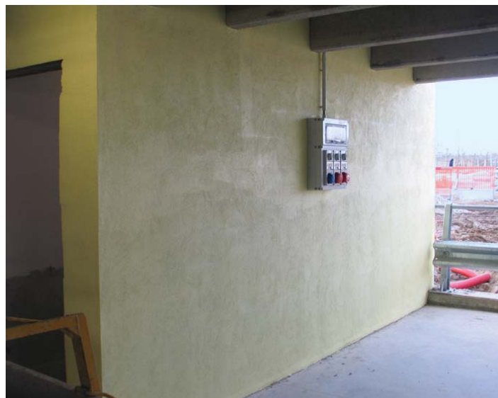
Interno di un padiglione della nuova fiera Pero-Rho, intonacato con MALTA BASTARDA FIBRORINFORZATA.
