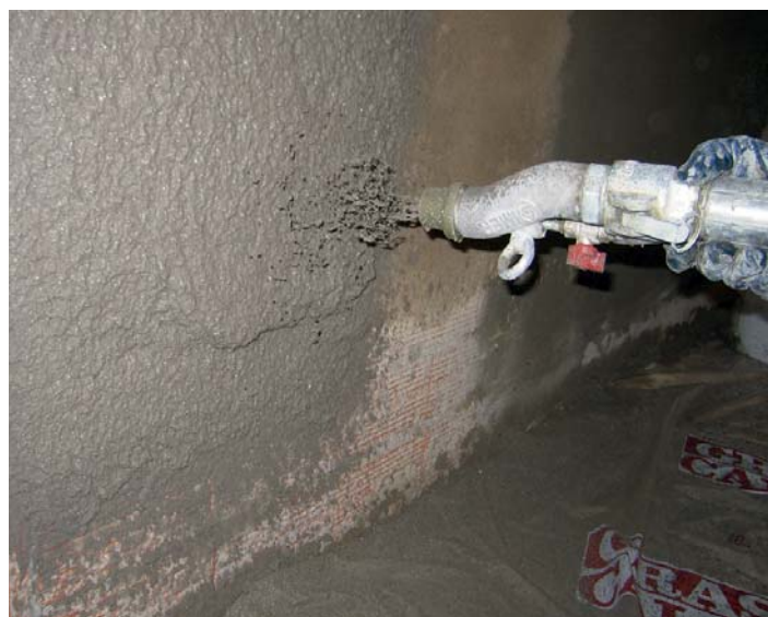
Benché studiata per essere applicata a mano, MALTA BASTARDA FIBRORINFORZATA può anche essere pompata con idonea pompa (tipo Step 120 di Imer International).
