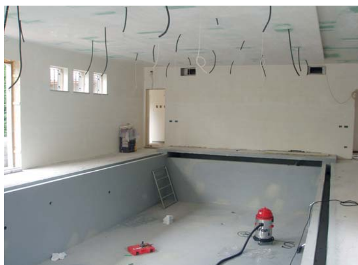
Rasatura di pareti in locale con destinazione d'uso a piscina. RASATUTTO BASE GESSO è infatti indicato anche in ambienti umidi.
