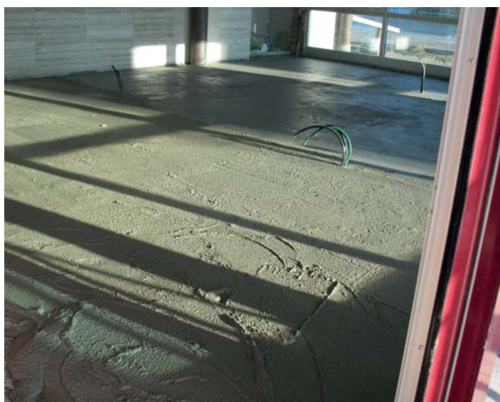
Realizzazione di sottofondo alleggerito con STRATOFOND.
