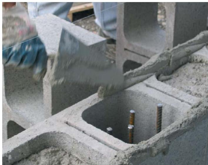
*Realizzazione di un muro in blocchi di cls con MALTABLOC. Particolarmente indicata anche per il riempimento dei blocchi-pilastrini in cls.*
