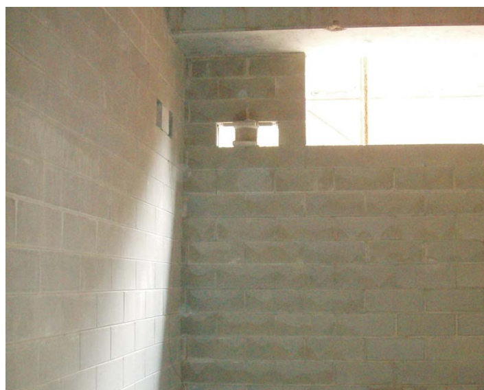
Muro in blocchi realizzato con malta di allettamento MALTABLOC in un centro commerciale.
