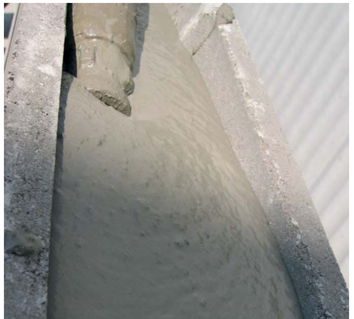
Pompaggio di COMPAT in blocco-correa armato.
