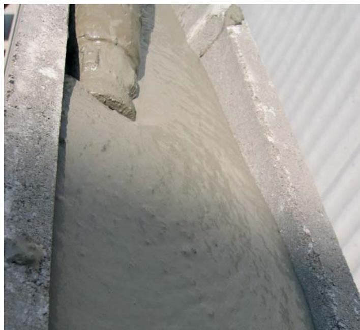
Pompaggio di COMPAT in blocco-correa armato.
