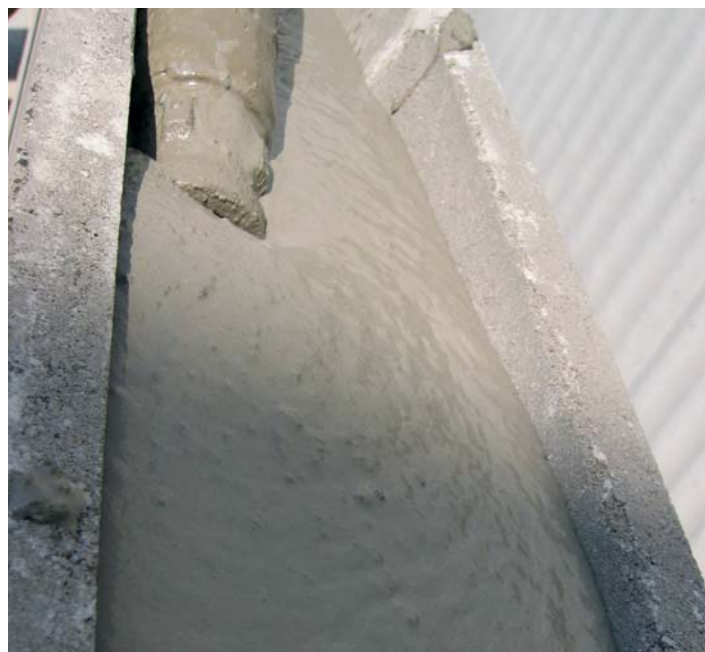
Pompaggio di COMPAT GRIGIO in blocco-correa armato.
