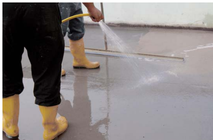
Taglio di pavimento industriale finito con SPOLVERO AL QUARZO e successivo lavaggio.
