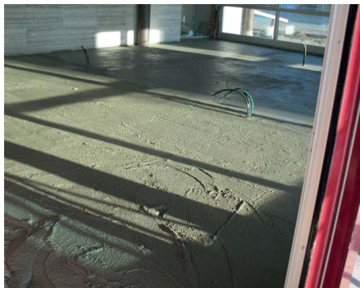
Realizzazione di sottofondo alleggerito con STRATOFOND.
