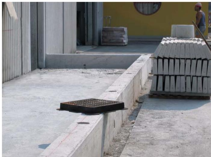
Réalisation de mur d'enceinte avec BETONRAPID. La rapidité de durcissement permet une utilisation presque immédiate de l'ouvrage.
