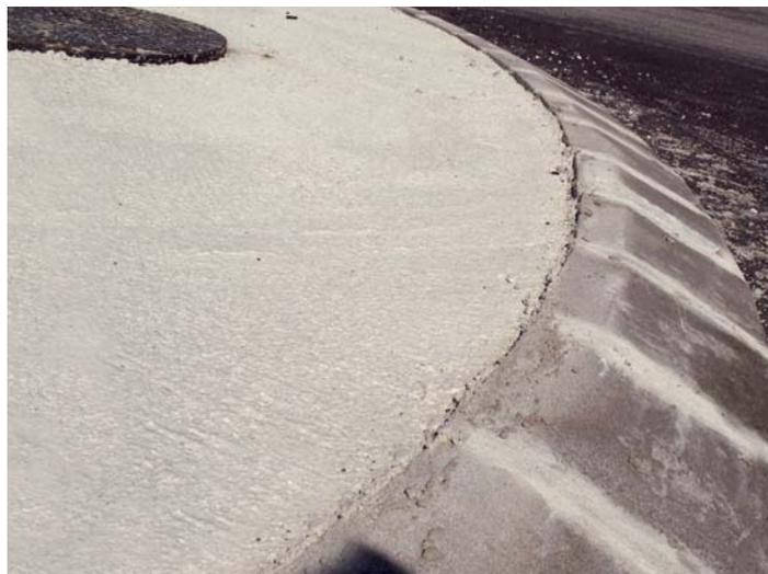
Travaux routiers réalisés avec BETONRAPID (rond-points et ancrage de regards) où la rapidité de séchage du produit est déterminante.
