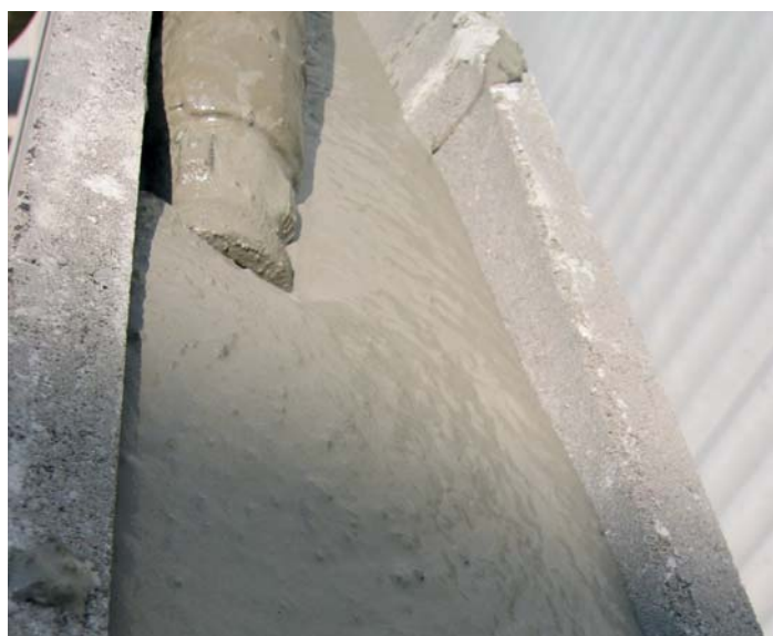
Pompage de COMPAT BLANC en bloc-guide armé
