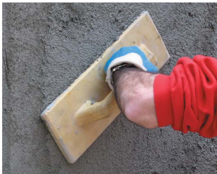
Intonacatura del locale per gruppo elettrogeno nel Palazzo Borromeo sull'Isola Bella (Stresa).
