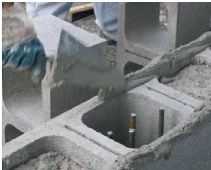
Realizzazione di un muro in blocchi di cls con MALTABLOC.
