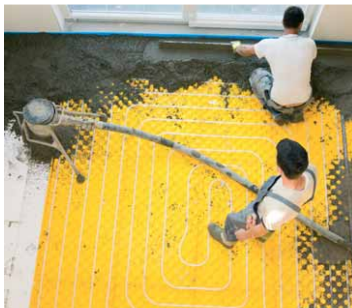
Posa di PAVIKLIMA per la realizzazione di pavimento riscaldato con pannelli radianti.
