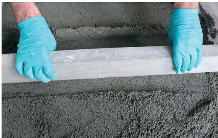
Impasto di PAVIX fibrinforzato con Turbomalt Evolution L 100
