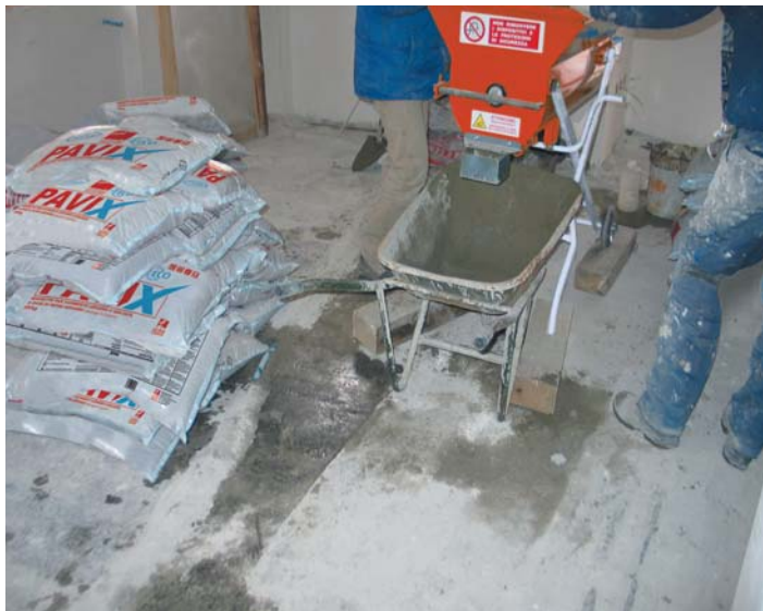
Impasto di PAVIX fibrinforzato con Turbomalt Evolution L 100
