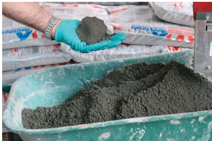
Verifica della consistenza "terra umida" dell'impasto.
