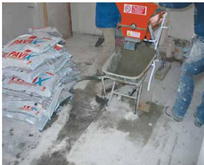
Impasto di PAVIX fibrorinforzato con Turbomalt Evolution L 100
