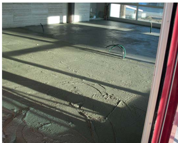
Realizzazione di sottofondo alleggerito con STRATOFOND.
