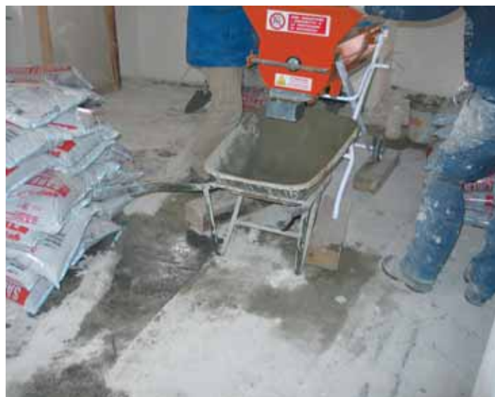
Impasto di SUPER SABBIA E CEMENTO FIBRORINFORZATO con TURBOMALT EVOLUTION.
