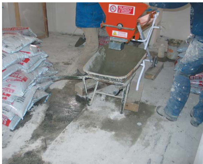
Gâchage de SUPER SABBIA E CEMENTO FIBRORINFORZATO avec TURBOMALT EVOLUTION.
