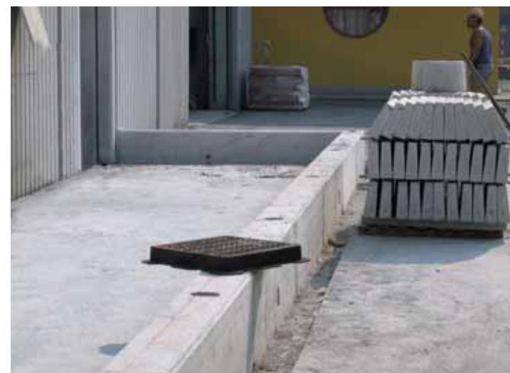
Realizzazione di muro di recinzione con BETONRAPID. La rapidità di indurimento permette un utilizzo quasi immediato del manufatto.
