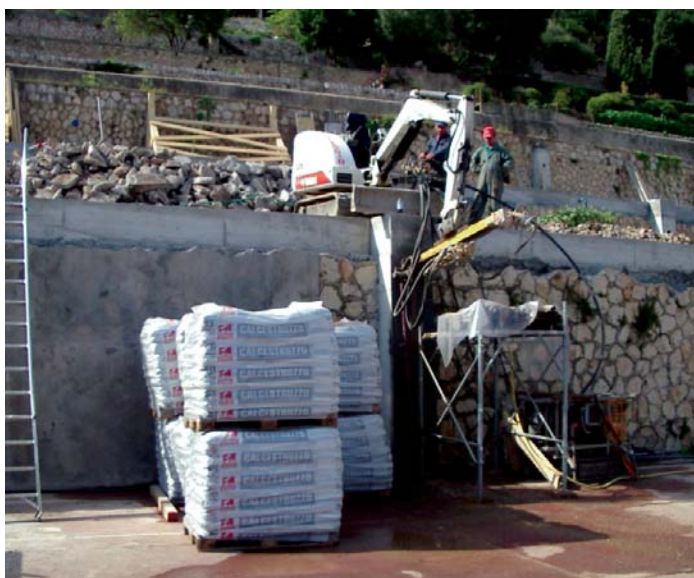
Terrassierung mit Stützmauern und Strebepfeilern aus strukturellem CALCESTRUZZO FIBRATO hergestellt.
