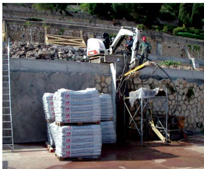
Terrassements réalisés avec des murs de soutènement et contreforts en CALCESTRUZZO FIBRATO structural.
