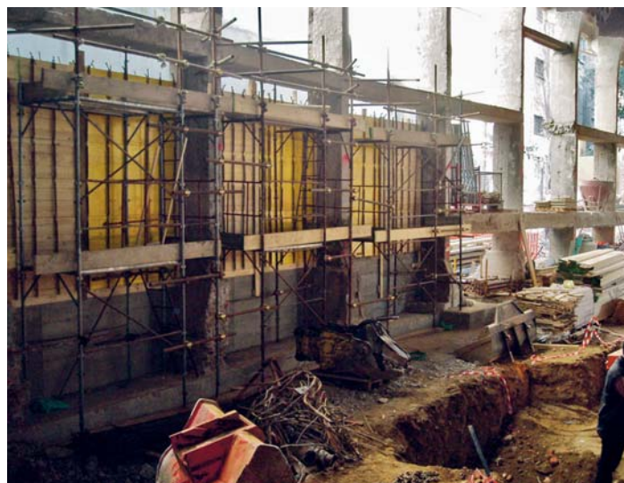
Murs de soutènement contre la terre réalisés avec CALCESTRUZZO FIBRATO structural dans la restructuration d'un espace commercial à Milan.
