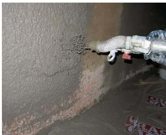
Le MALTA BASTARDA FIBRORINFORZATA renforcé de fibres peut être appliqué manuellement ou avec une pompe appropriée (type Step 120 d'Imer International).
