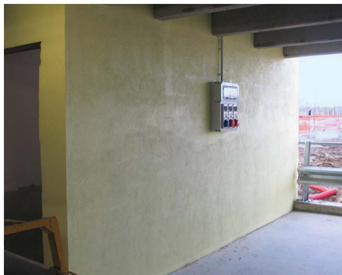
Intérieur d'un pavillon de la foire Pero-Rho, enduit avec du MALTA BASTARDA FIBRORINFORZATA.
