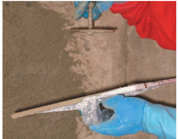
VERPUTZ-Auftrag auf einer calcestruzzo mit MALTA DI CEMENTO.
