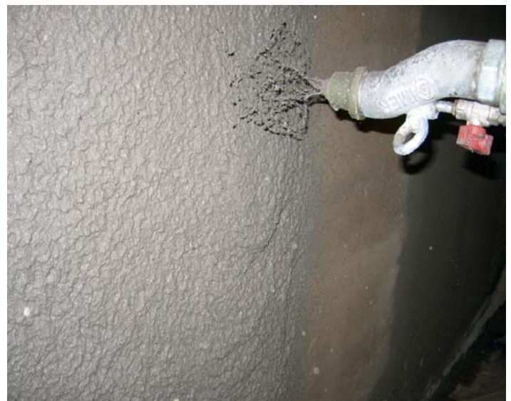
MALTA DI CEMENTO kann einer geeigneten Pumpe gepumpt werden (Typ Step 120 von Imer International).
