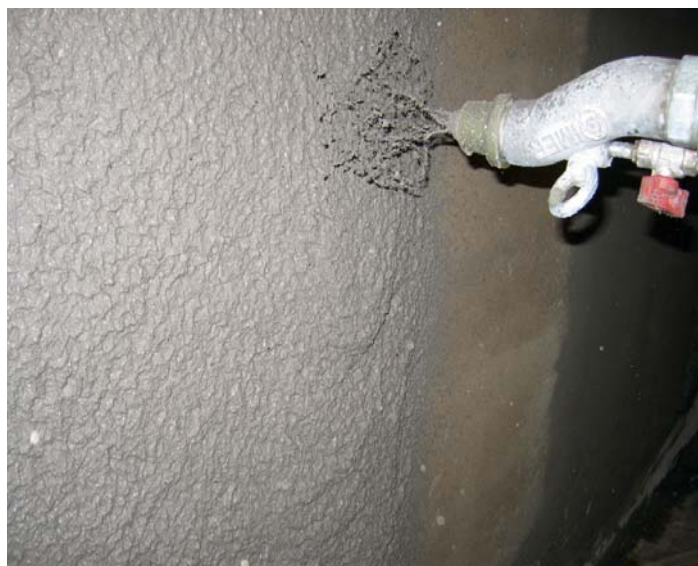
MALTA DI CEMENTO peut être appliqué avec une pompe appropriée (type Step 120 d'Imer International).
