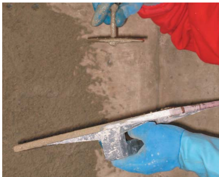
Enduit réalisé sur le mur en CLS avec MALTA DI CEMENTO.
