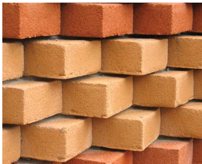
Une trame polychrome en briques posées avec du MALTA A VISTA GRIS (Cantù-CO).
