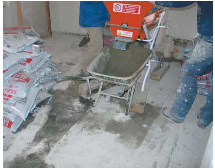
Mischung von SUPER SABBIA E CEMENTO FIBRORINFORZATO mit TURBOMALT EVOLUTION.
