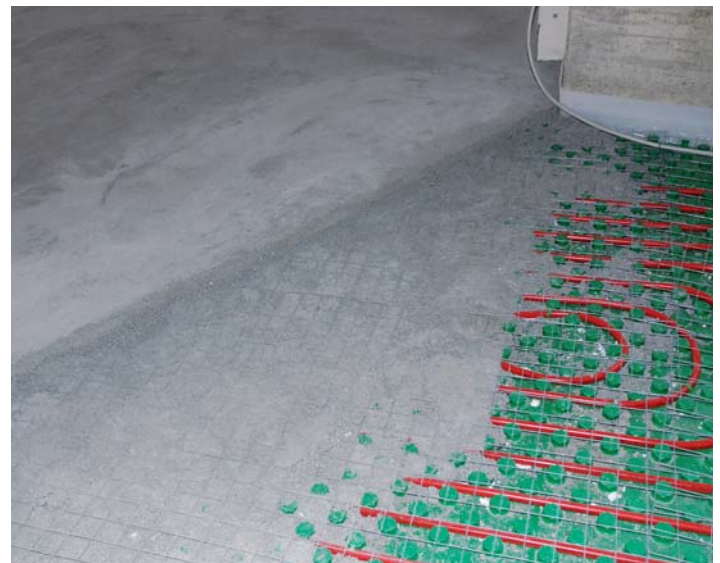
Verlegung von SUPER SABBIA E CEMENTO FIBRORINFORZATO für die Herstellung von Bodenheizungsplatten.
