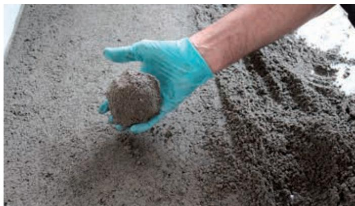
Il massetto impastato deve avere una consistenza "terra umida".
