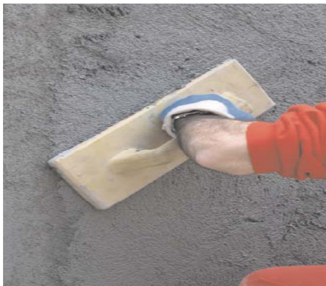
Intonacatura del locale per gruppo elettrogeno nel Palazzo Borromeo sull'Isola Bella (Stresa).
