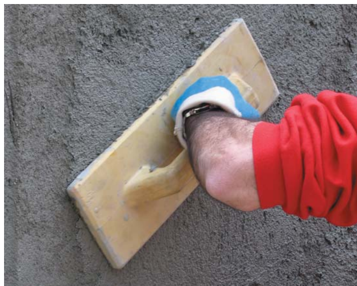
Intonacatura del locale per gruppo elettrogeno nel Palazzo Borromeo sull'Isola Bella (Stresa).
