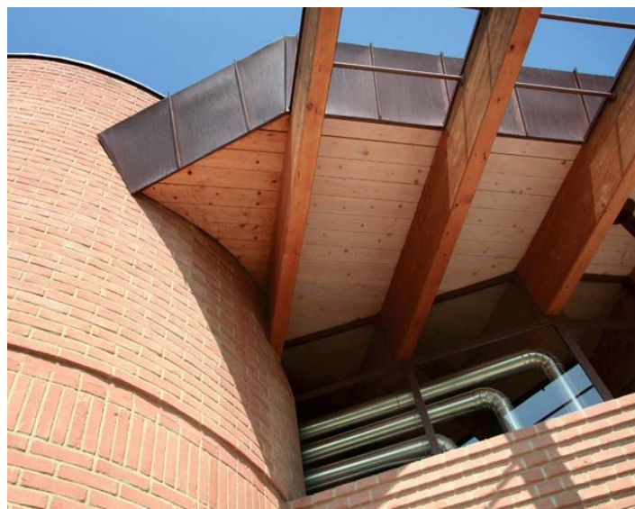
Particolare di una facciata realizzata con mattoni faccia a vista allettati con MALTA A VISTA OCRA (La Morra-CN)
