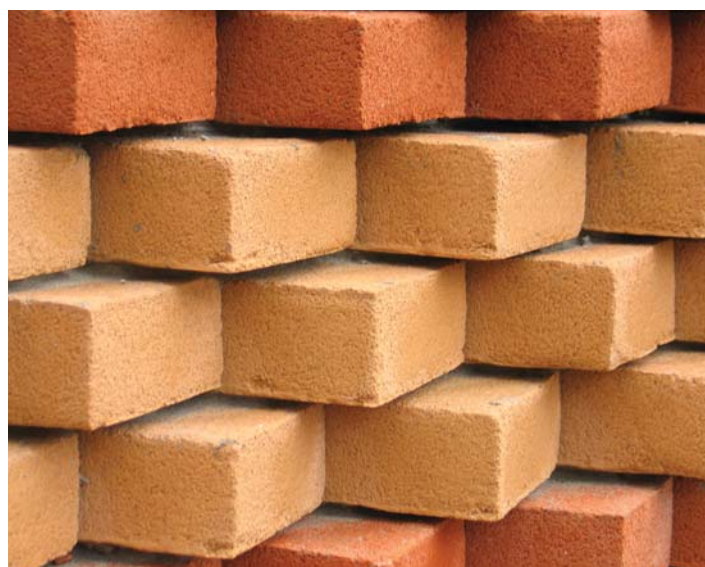
Una trama policroma in mattoni posati con MALTA A VISTA GRIGIA (Cantù-CO)
