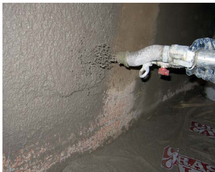
Benché studiata per essere applicata a mano, MALTA BASTARDA FIBRORINFORZATA può anche essere pompata con idonea pompa (tipo Step 120 di Imer International).
