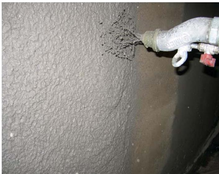
MALTA DI CEMENTO è studiata appositamente per un'applicazione manuale ma può anche essere pompata con idonea pompa (tipo Step 120 di IMER International).
