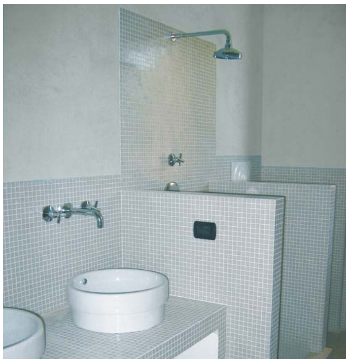
Enduit de finition intérieur réalisé avec MALTA FINE.
