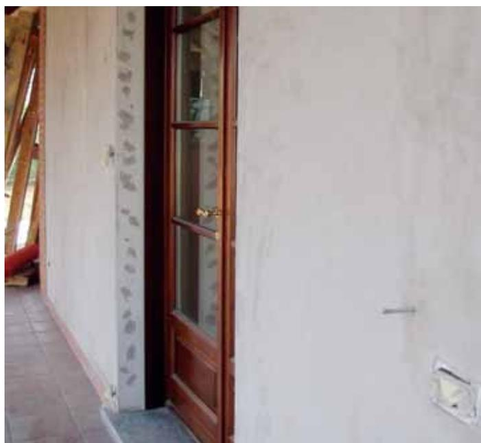
Prima fase di rasatura di muro esterno con FIBROFIN miscelato con RASATUTTO SUPERIOR.
