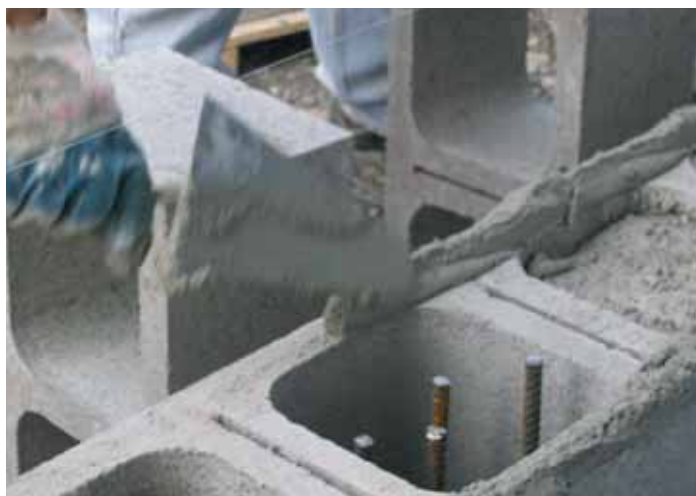
Realizzazione di un muro in blocchi di cls con MALTABLOC.
