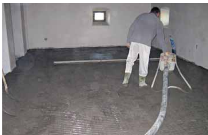
Impasto di SUPER SABBIA E CEMENTO FIBRORINFORZATO con TURBOMALT EVOLUTION.
