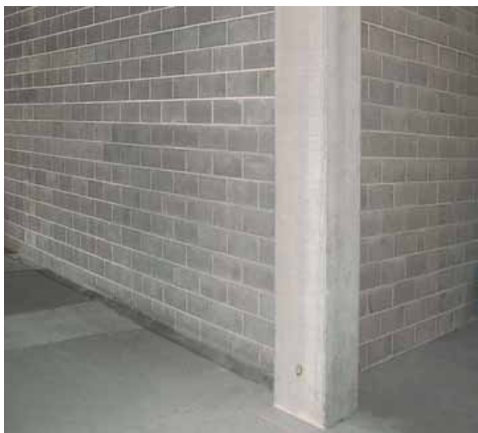
Realizzazione di un muro in blocchi di cls con MALTABLOC.
