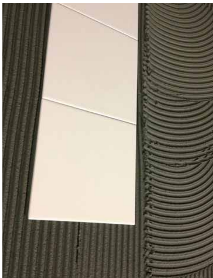
Posa di ceramica di grande formato con LACOLLA
