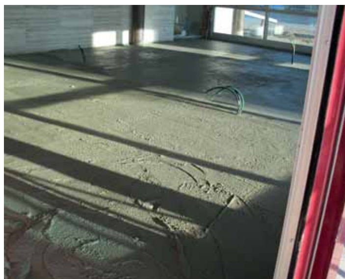
Realizzazione di sottofondo alleggerito con STRATOFOND.
