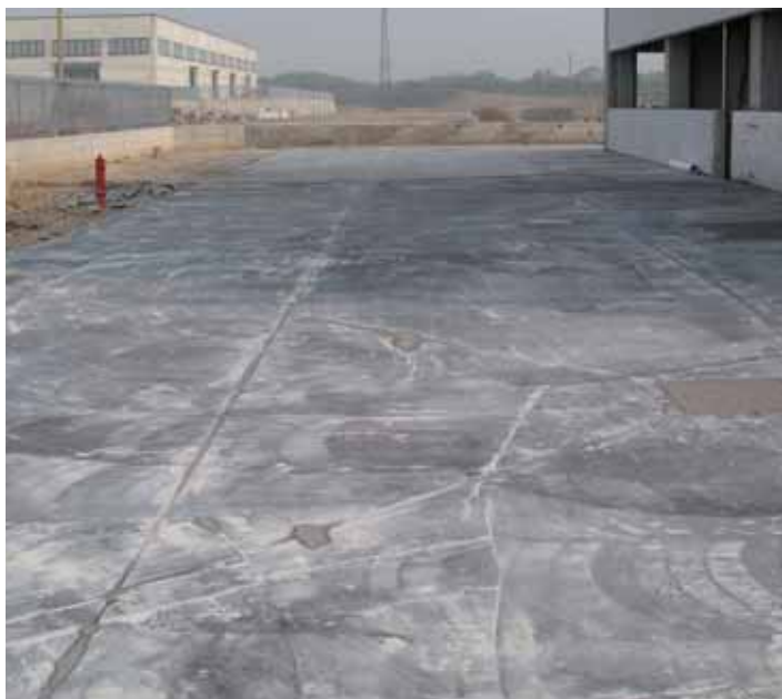
Taglio di pavimento industriale finito con SPOLVERO AL QUARZO e successivo lavaggio.
