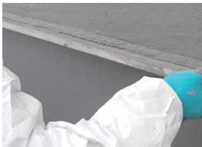
Intonacatura a macchina con MALTAOK FIBROMAC di una tramezza in laterizio.
