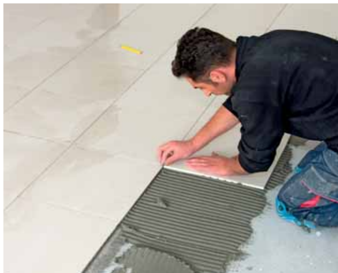
Posa di ceramica di grande formato con LACOLLA
