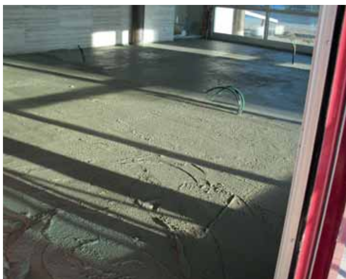
Realizzazione di sottofondo alleggerito con STRATOFOND.
