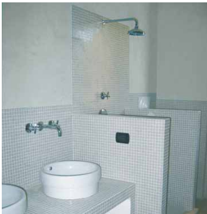
Intonaco di finitura interno realizzato con MALTA FINE.
