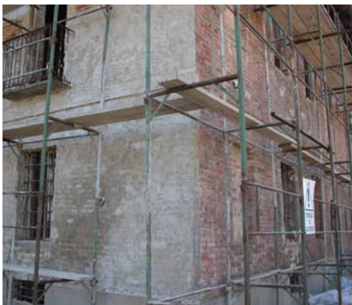
Stilatura di mattoni con MALTA ANTICA SILIGRAS in un edificio del XVIII secolo (prima e dopo l'intervento).
