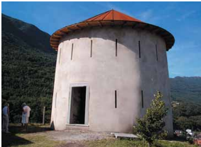
Recupero di un Fortino della Fame a Bellinzona, Svizzera. MALTA ANTICA SILIGRAS è stata utilizzata come intonaco esterno a vista.
