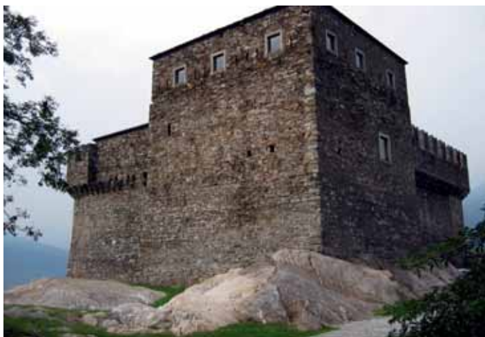
Stilatura con MALTA ANTICA SILIGRAS dei blocchi in pietra delle mura del Castello di Sassocorbaro a Bellinzona.
