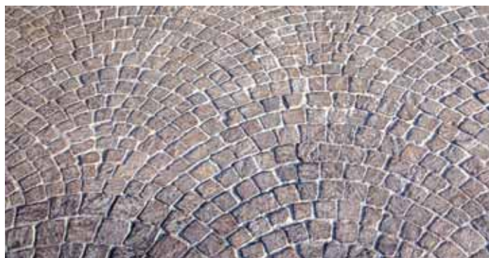
Formazione dello strato di allettamento di una pavimentazione in porfido.
