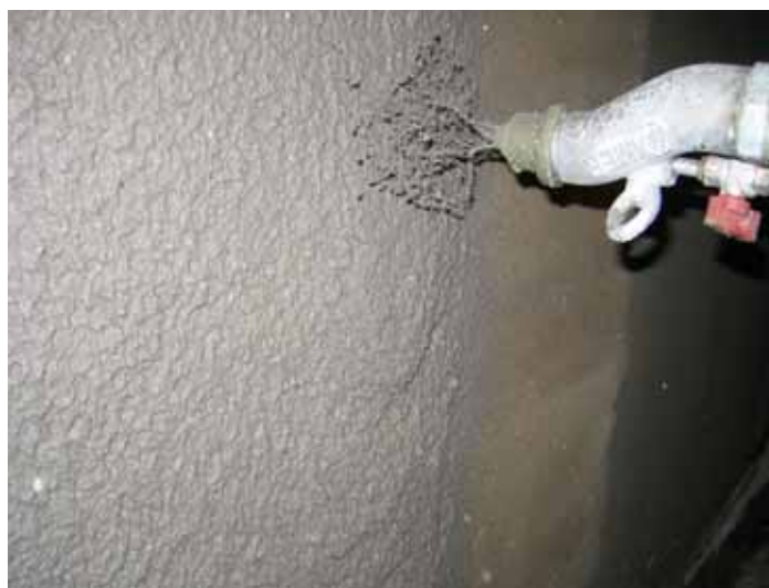
MALTA DI CEMENTO può essere pompata con idonea pompa (tipo Step 120 di IMER International).
