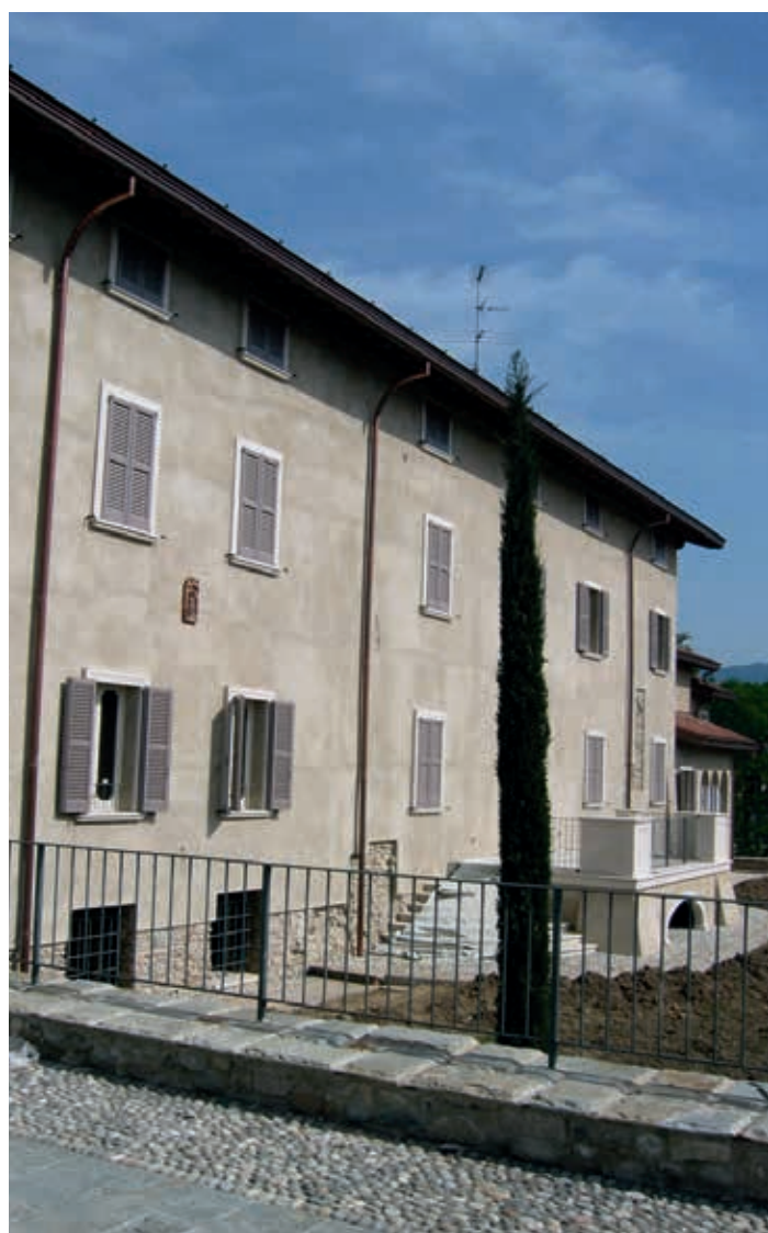
Ristrutturazione di una villa del 1700. Intonaco esterno e interno realizzato con MALTA ANTICA SILIGRAS lasciata a vista.
