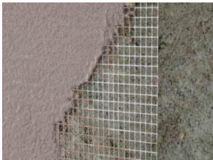
Intonaco eseguito su parete in calcestruzzo con MALTA DI CEMENTO.
