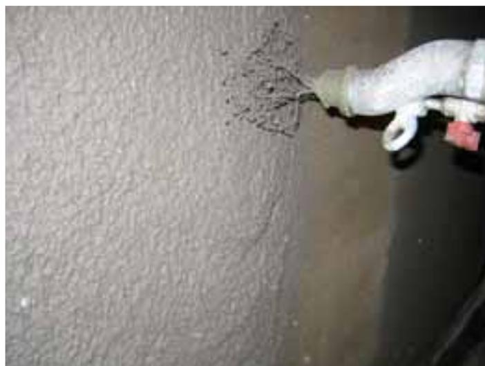
MALTA DI CEMENTO può essere pompata con idonea pompa (tipo Step 120 di IMER International).
