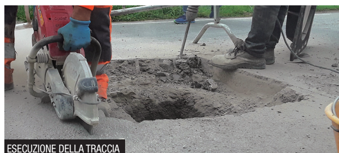
ESECUZIONE DELLA TRACCIA
