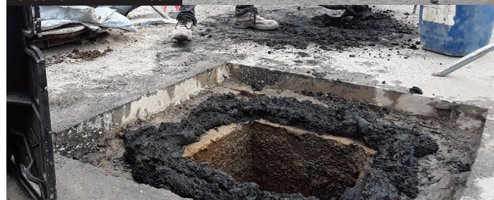
POSA DI BETONROAD SUL POZZETTO
