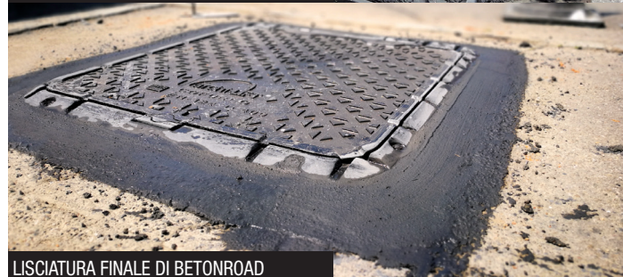
LISCIATURA FINALE DI BETONROAD
