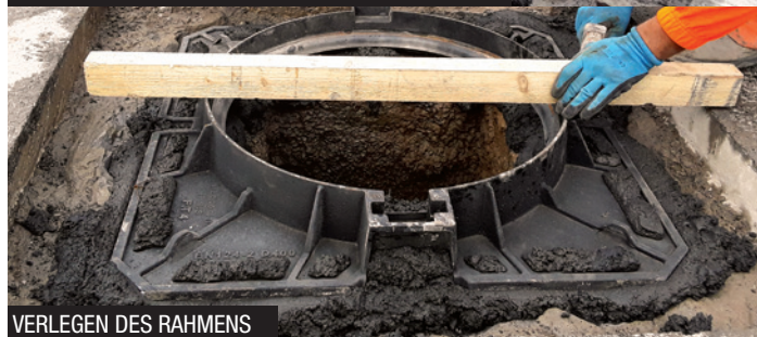
VERLEGUNG VON BETONROAD AUF EINEM SCHACHT
