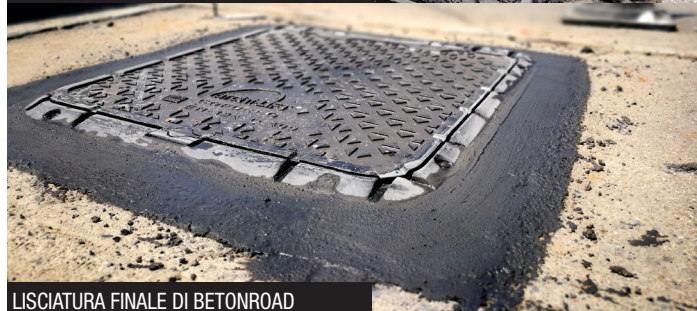
LISCIATURA FINALE DI BETONROAD
