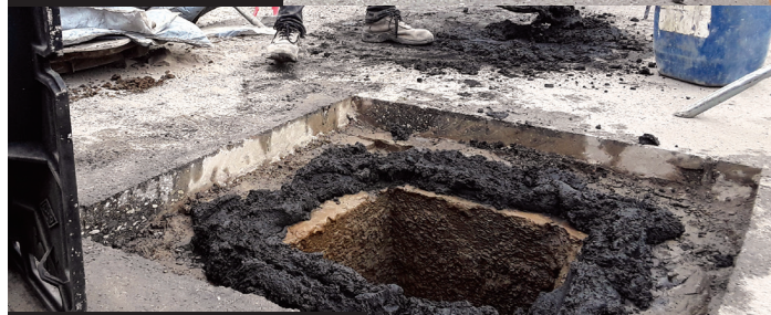
POSA DI BETONROAD SUL POZZETTO
