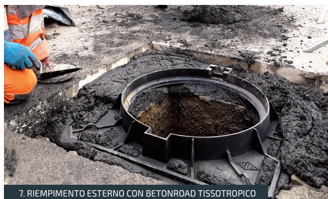
7. RIEMPIMENTO ESTERNO CON BETONROAD TISSOTROPICO
