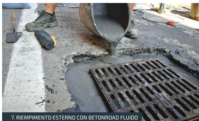
7. RIEMPIMENTO ESTERNO CON BETONROAD FLUIDO
